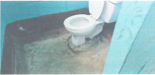
Foto 3: cambio de taza, lavamanos, sustitucion de piso, pintura de puerta, pintura de pared
