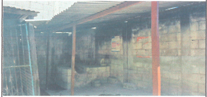
Foto 2: cambio de estufa, chimenea, pila, piso, reja frontal, techo y pintura de paredes
