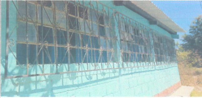
Foto 1: sustitución de vidrios, pintura de ventanillas, repello de pared pintura y sustitucion de torta de acera
